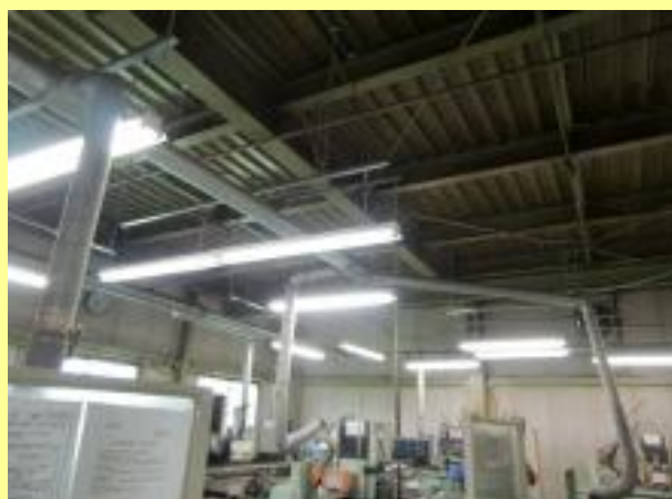
＜施工後＞作業員中心の照明配置。 全てWエコ照明に取替。明るく無駄もない。 通路部分は不要なので器具数削減。
